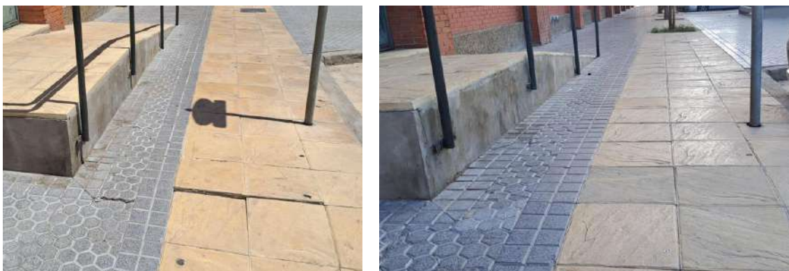
En la acera de la calle Arroyo, había losetas levantadas que pueden provocar y ya han sido reparadas
