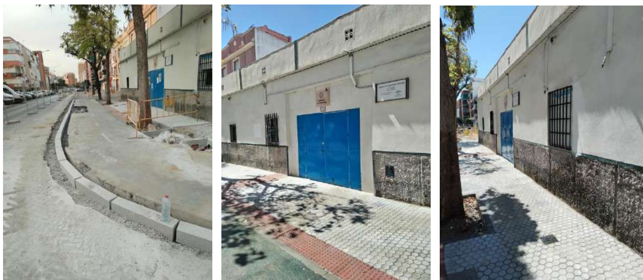
La colocación del acerado en el local social se ha realizado en el mes de agosto
